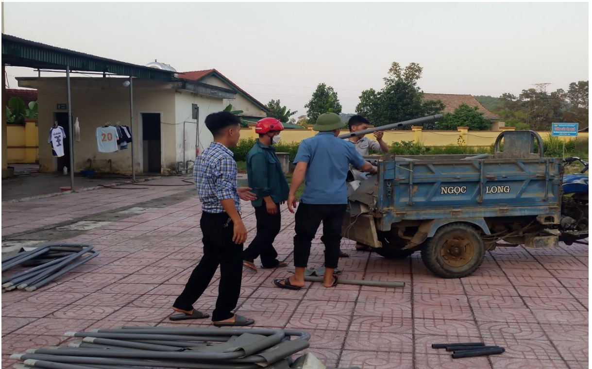
(Đoàn viên thanh niên vận chuyển và lắp đặt bể)
